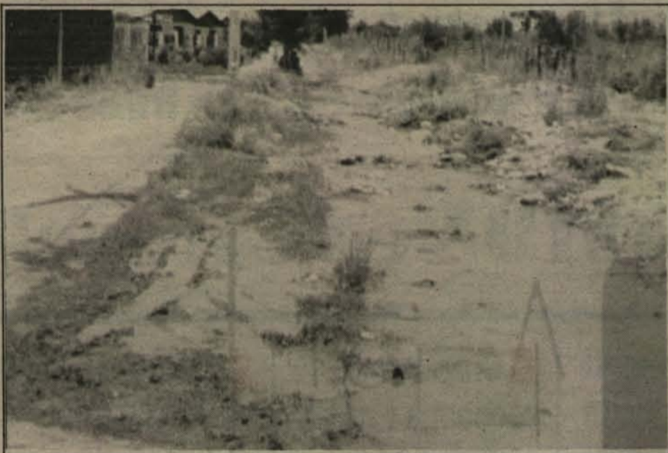
Los vecinos de La Florida temen que la calle José Miguel Carrera, en la intersección con Bahía Catalina, termine efectivamente transformándose en un brazo de mar. La vía, en una extensión de 400 metros, se halla bajo el agua y los escombros, creando todos los problemas que son de imaginar.
