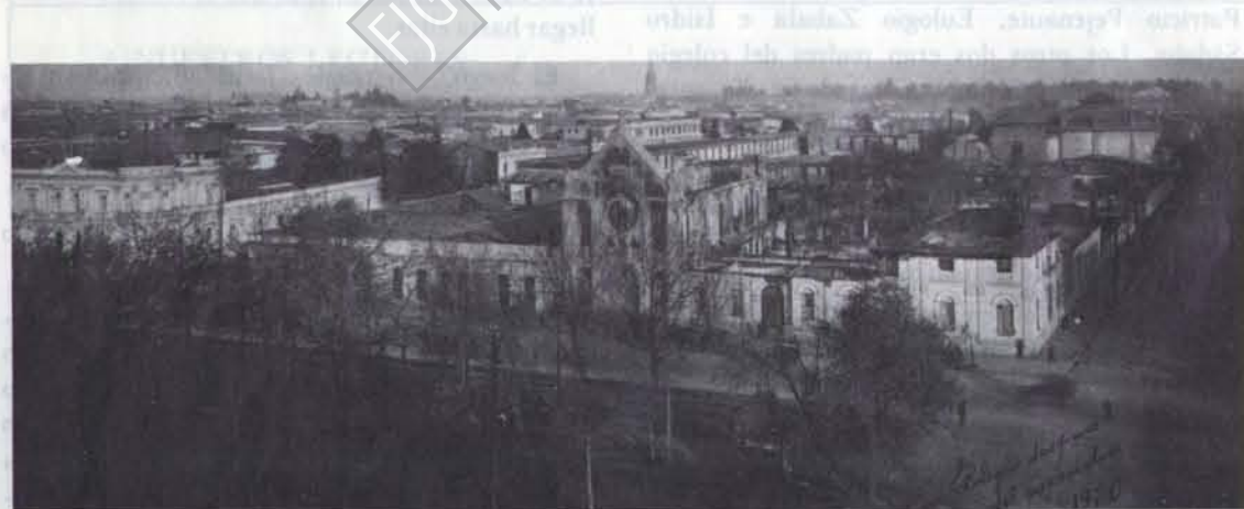
Estado en que quedó el Colegio luego del incendio.
