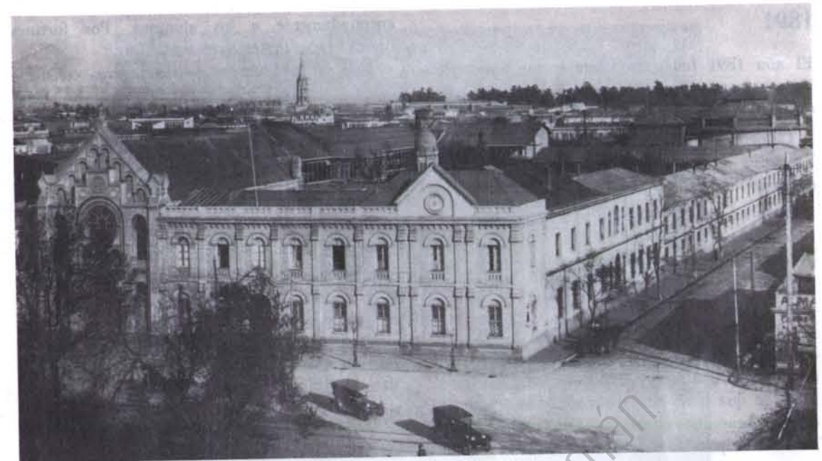
Vista panorámica de la fachada.
